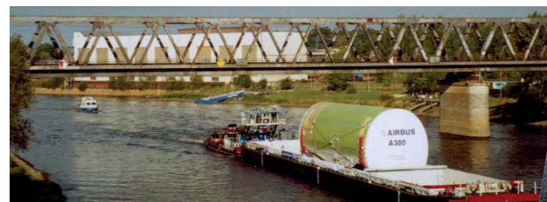
Elbkilometer 257,81- Eisenbahnbrücke 1968 bis heute
