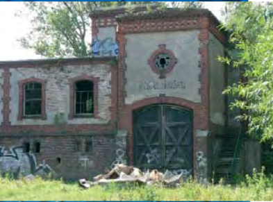
Waggonhebeanlage im Wallwitzhafen
