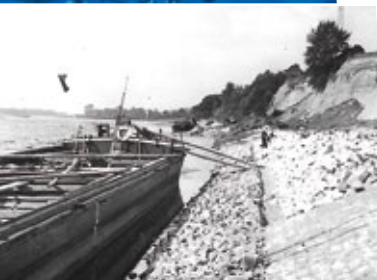
Pflastern der Deckwerksböschung 1935
