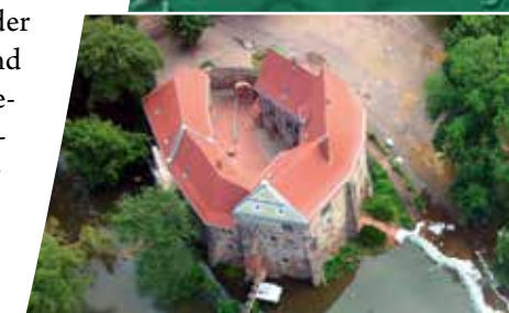
Dach komplett Hochwasser 2013
